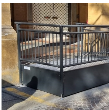
Copertura laterale sotto
