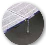
Pies de altura ajustable con posicionamiento automático
